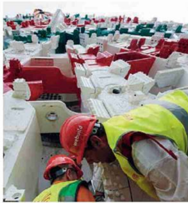
Oltre 36mila I lavoratori impegnati direttamente nei cantieri
